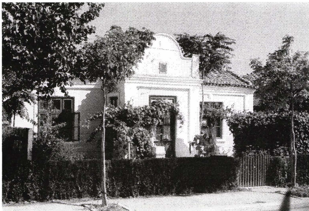
Maison neuve typique pour les villages de la Doubroudja (foto Paul Petrescu, 1974)
